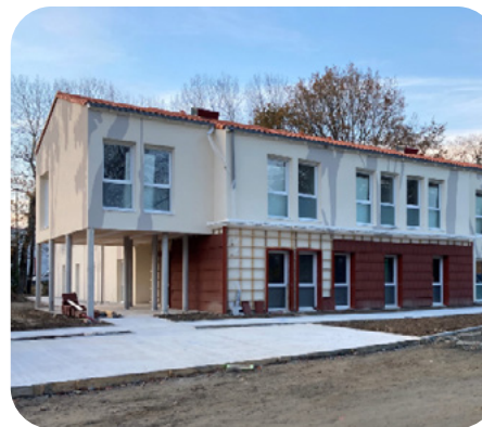
Le bâtiment des LAM sera achevé en 2023
